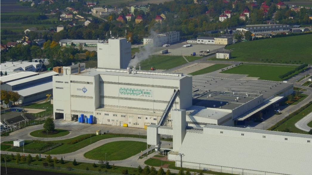
*Die Firma Dolina Nidy Sp.z.o.o. erweitert im polnischen Pinczow ihre Kapazitäten zur Gipsproduktion. Um noch flexibler im Rohstoffeinsatz agieren zu können integriert Grenzebach eine neue Stromtrocknungsanlage für die Verarbeitung von REA-Gips in das bereits vorhandene Kalzinierungsgebäude.*
